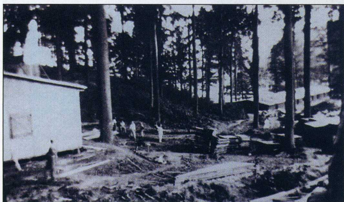
Construction des baraques du camp de Dora. Photo prise par Jan Halupka au printemps 1944.
