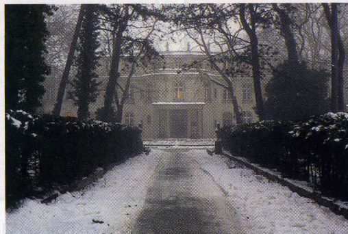
La villa de Wannsee (Photo FMD janvier 2010)
