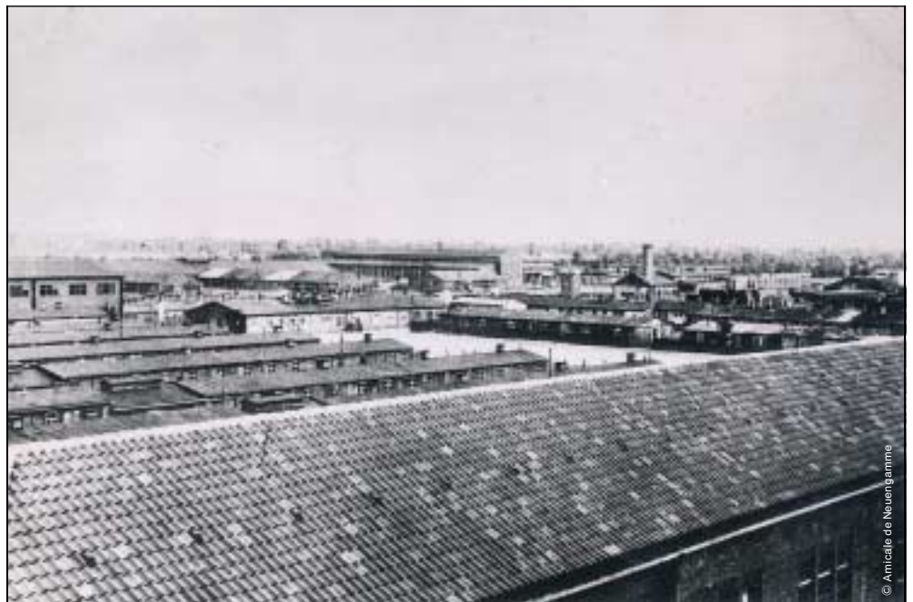
Vue générale ouest-est du camp de Neuengamme. Au premier plan, toiture du bâtiment des Blocks 1 à 4.
