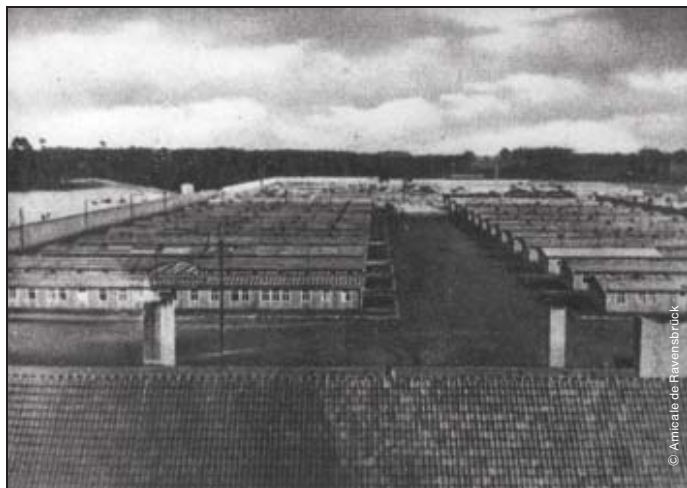
Camp principal. Vue générale des baraques.
