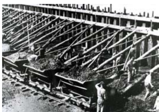
> Détenus de Sachsenhausen construisant un quai au niveau de l'écluse de Lehnitz sur le canal Oder-Havel près d'Oranienburg en mai 1940. ©Gedenkstätte Sachsenhausen
